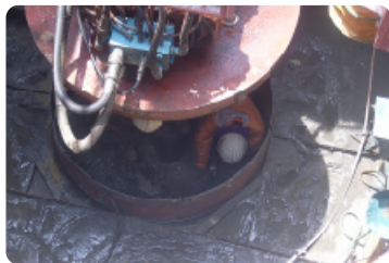
残土吸引状況
