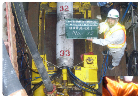
推進管据付完了
