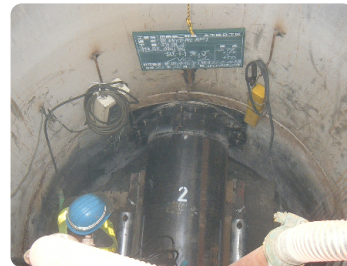
\phi 2,000\text{mm} 立坑ケーシングより推進中
