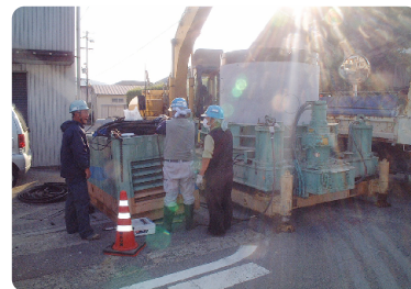
作業前の打合せ状況
