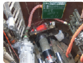
推進管据付完了
