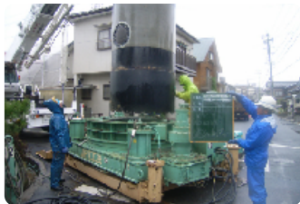
刃口建て込み
