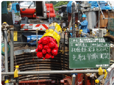
推進マシン投入状況
