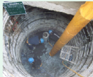
ライナープレート掘削
