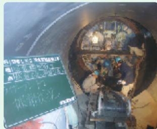
管内でライナープレート掘削
