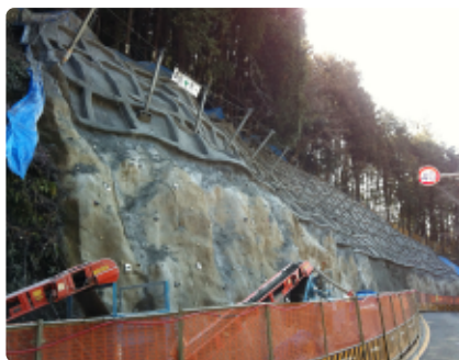
施工中現場状況
