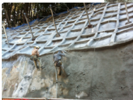
法面吹付状況
