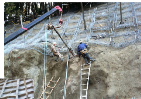
ロックボルト打設状況
