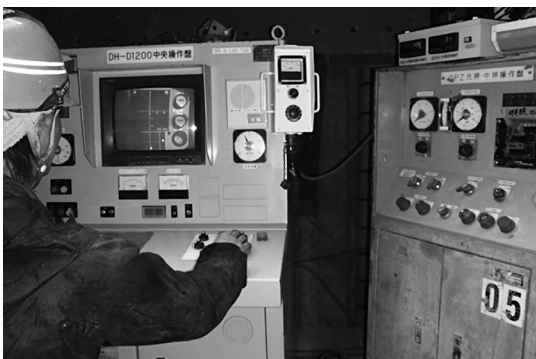
写真-1 作業状況①
