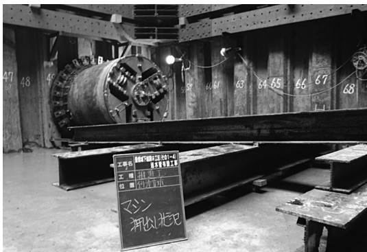
写真-5 掘進機到達状況
